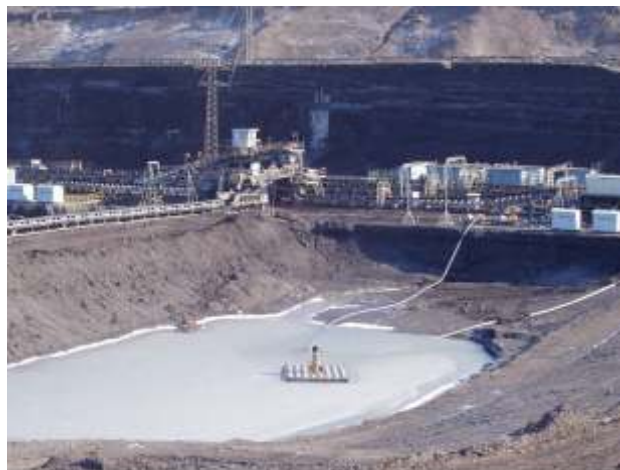
Obr. 6. Použití rozvodů čerpacích stanic řady RČS pro přečerpávání dešťové vody v areálu Doly Nástup Tušimice.
